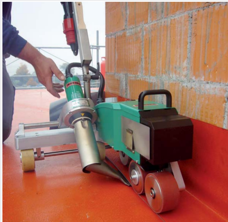
Gracias a su delgado diseño, se puede soldar hasta a 110 mm de distancia de la pared.
